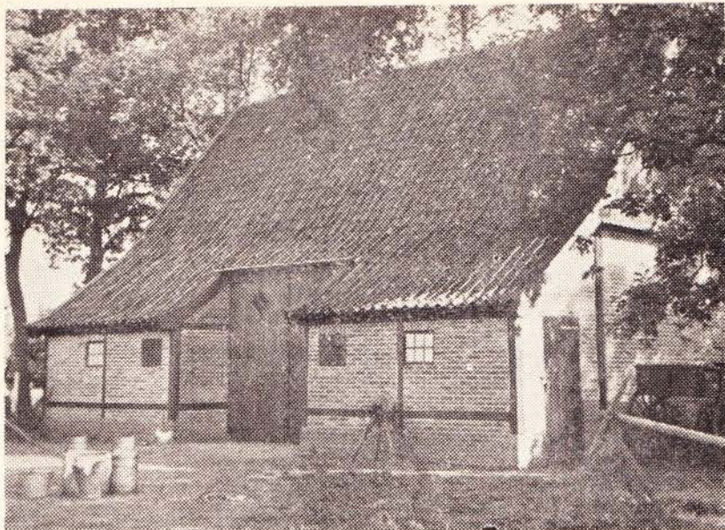
Nieuwe schuur van architect J. Jans (Almelo) in oude stijl bij het erve Lammerink, Usselo.
